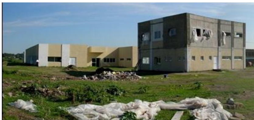
Figura 28. Estado de la obra a junio del 2009
