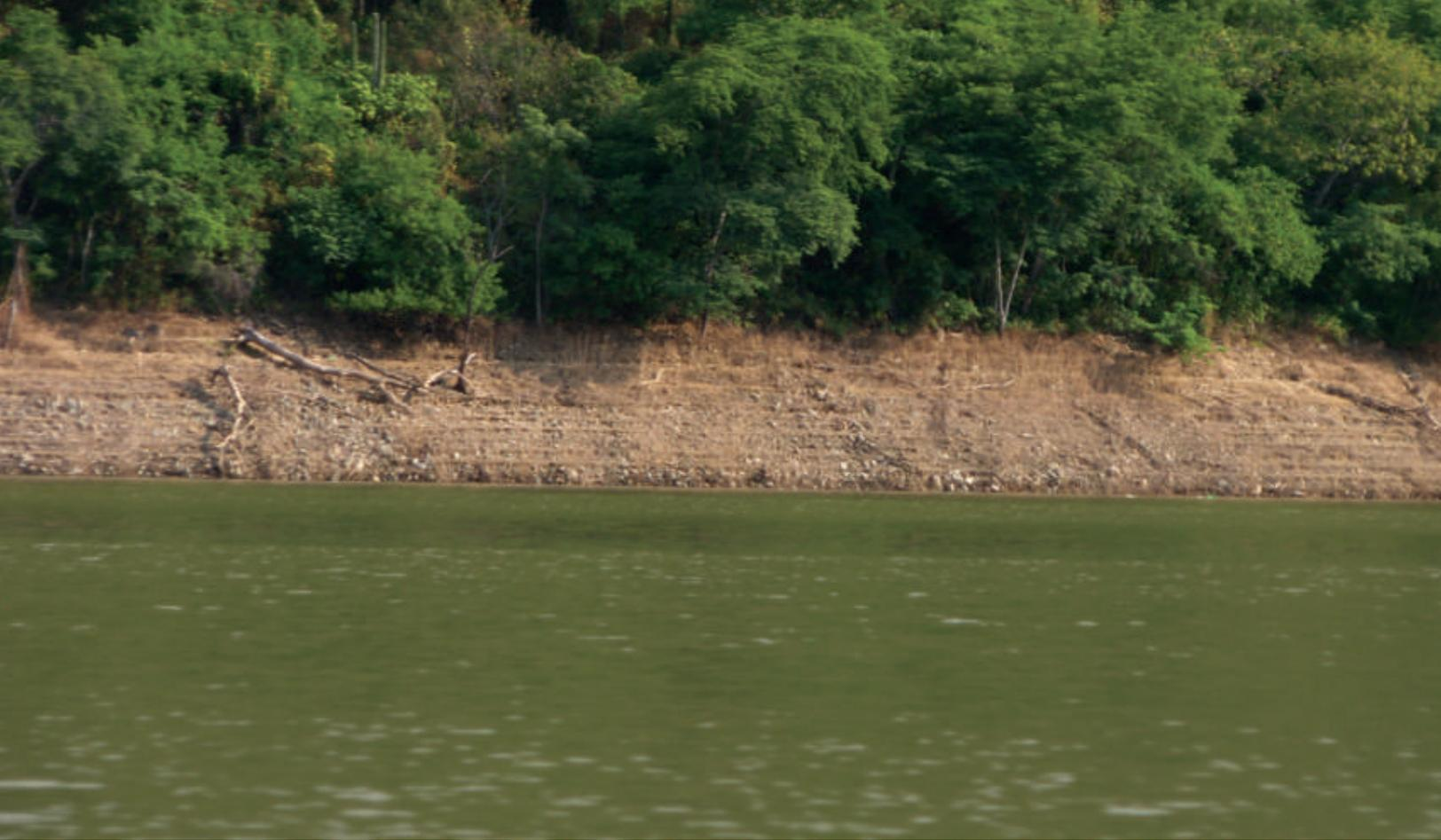
Erosión y formación de escalones en las laderas del embalse debidas a cambios del nivel del agua.
