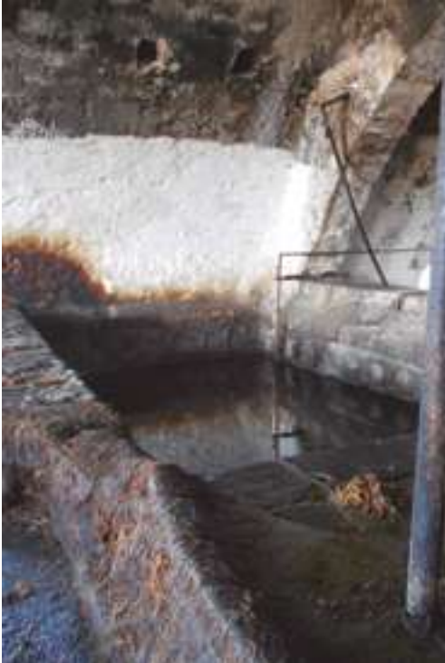
LAVADERO DE LA FABRICA LAGUNA SECA, CHARCAS, SAN LUIS POTOSÍ
