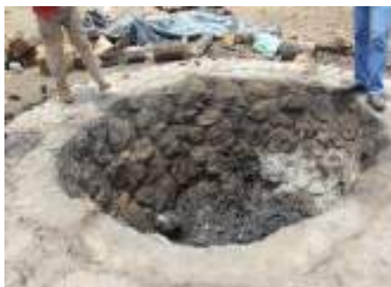
Horno de piso ademado con cemento y roca volcánica
