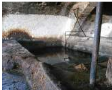
Lavadero de la Fabrica Laguna Seca. Charcas, San Luis Potosí.
