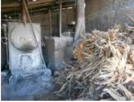
Plantas de maguey seco utilizadas como combustible en calderas.
