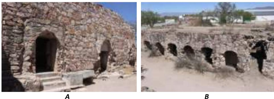
Figura 24. Área de cocimiento. **A)** Batería de tres hornos ubicada a un costado de la finca principal. **B)** Se observa el conjunto de 7 hornos de cocimiento de la antigua “Fábrica de Melchor”, ubicados frente a las instalaciones de la fábrica (Fotografías: Juan Gallardo).
