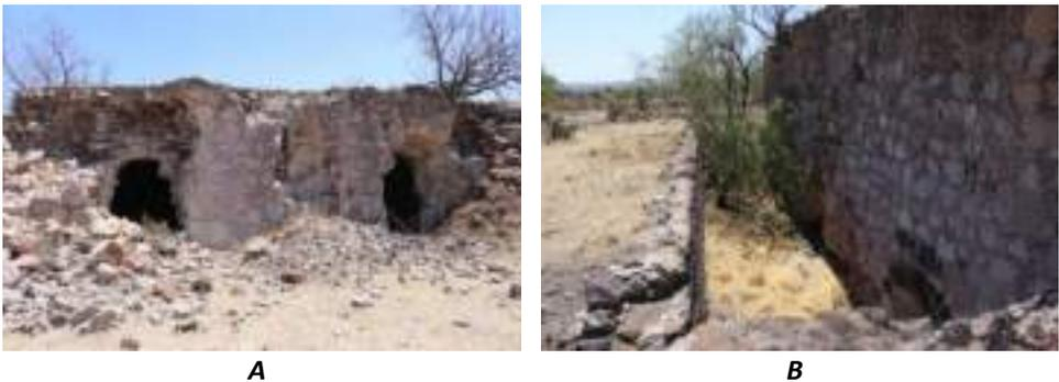
Figura 15.- Hornos de cocimiento. **A)** Parte frontal de la batería de hornos pertenecientes al “Rancho de Vino”. **B)** Parte trasera de la batería de horno donde se ubican las hornillas por donde se alimentaba la leña durante el cocimiento. (Fotografías: Juan Gallardo).
