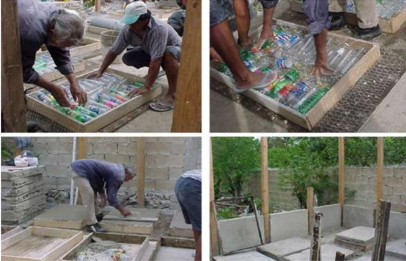
**Figura 5.** Proceso de construcción de una placa. Iniciando con la imagen de arriba a hacia abajo y de izquierda a derecha: Posicionado de botellas vacías de PET sobre una capa de mortero fibrorreforzado y malla metálica, colocación de la segunda capa de malla metálica, acabado superficial final de la segunda capa de mortero fibrorreforzado y erección de placas ya terminadas.
