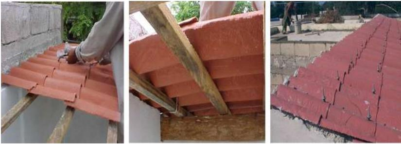
**Figura 7.** Proceso de instalación de las láminas acanaladas fabricadas a base de un polímero fibrorreforzado y relleno de carga mineral. Nótese la sujeción de las láminas utilizando birlos de acero, típicos en la instalación de láminas de zinc.
