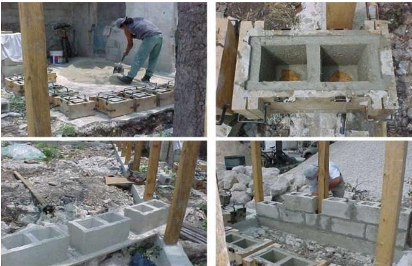
**Figura 6.** Proceso de construcción de un block fibrorreforzado. Iniciando con la imagen de arriba a la izquierda en el sentido horario: llenado de los moldes, proceso de desmoldado, y pegado de bloques terminados en el muro.
